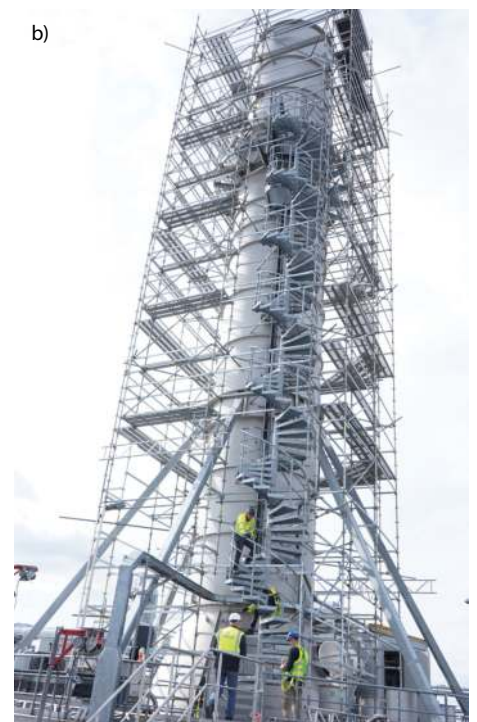
Fot. 1. Rusztowanie wokół stalowego komina o wysokości 50 m i średnicy 3,6 m, przeznaczone do robót spawalniczych
