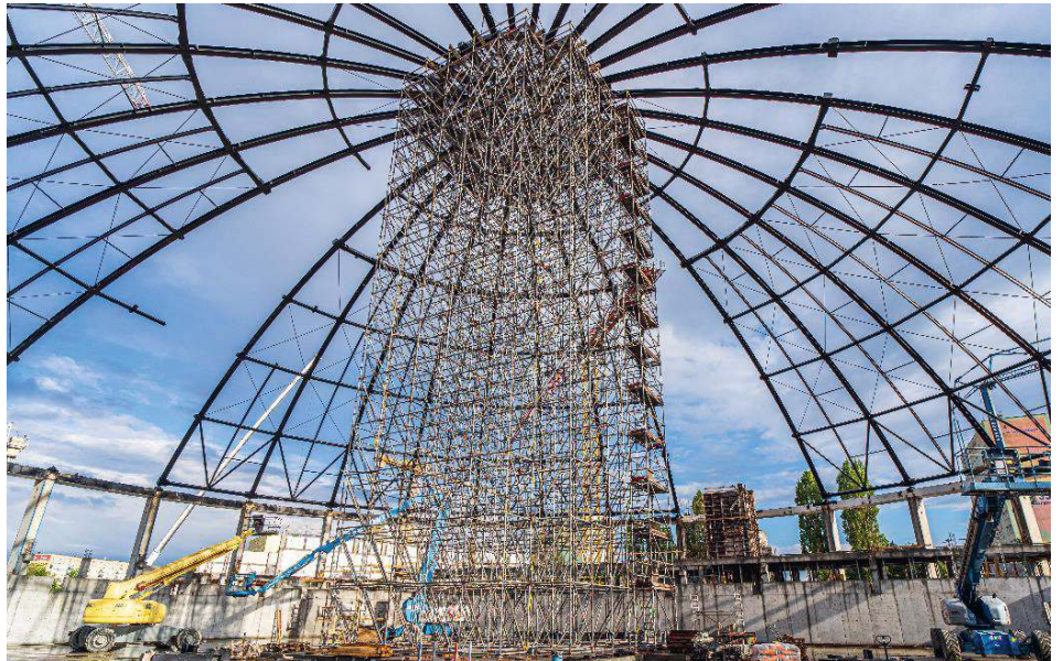
Fot. 2. Wieża o wysokości 27,5 m wykonana z rusztowania
