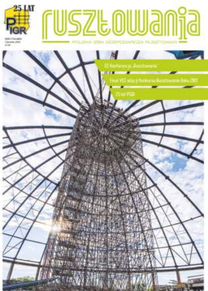
Rys. 3. Widok rusztowania podczas scalania konstrukcji kopuły, zaprezentowany na okładce 62 numeru kwartalnika „Rusztowania”
