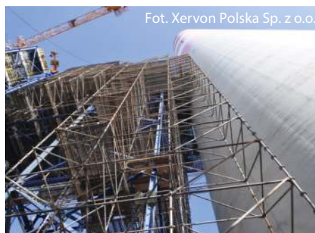
Fot. 1. Konstrukcja rusztowania modułowego do modernizacji i wymiany kanału spalin między absorberem a kominem na istniejącej instalacji w Zakładach Azotowych w Puławach
