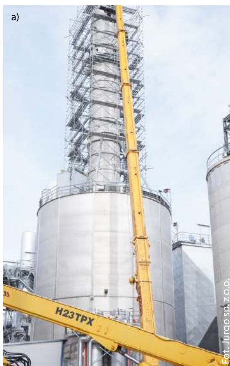
Fot. 1. Rusztowanie wokół stalowego komina o wysokości 50 m i średnicy 3,6 m, przeznaczone do robót spawalniczych
