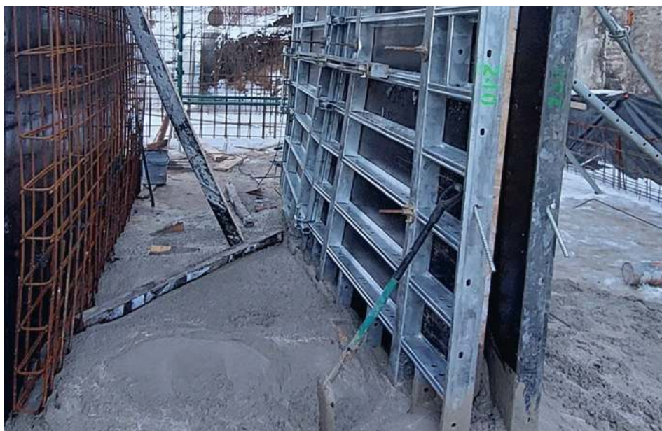
Fot. 2. Jedną z najczęstszych przyczyn awarii deskowania ściennego jest użycie ściągow o nieodpowiedniej nośności
