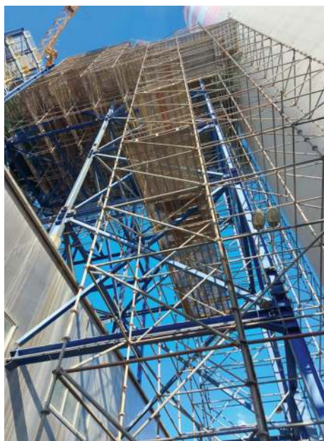
Fot. 1. Konstrukcja rusztowania modułowego do modernizacji i wymiany kanału spalin między absorberem a kominem na istniejącej instalacji w Zakładach Azotowych w Puławach
