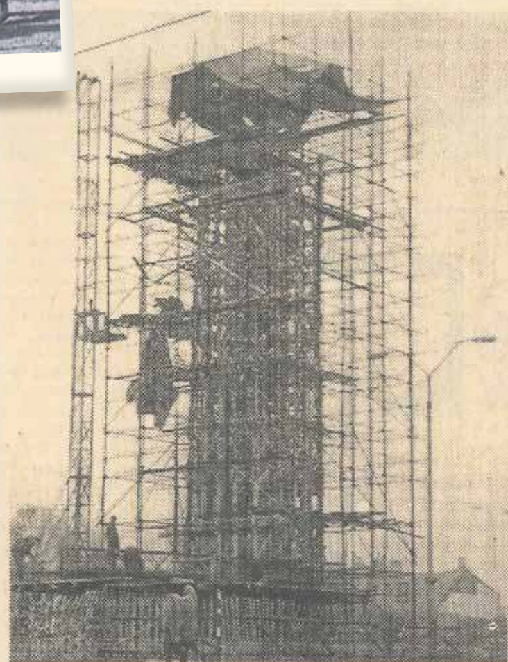
Na placu Obrońców Stalingradu trwają intensywne prace przy budowie pomnika Bojowników o wyzwolenie społeczne i narodowe.
