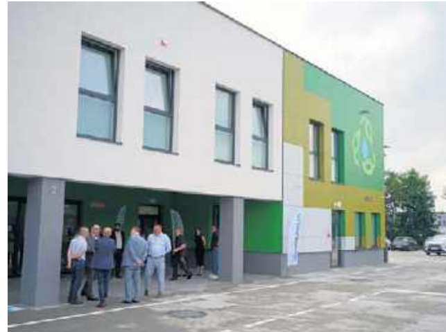
Nowy obiekt to kompleks, który połączy funkcje biurowe z Punktem Selektywnej Zbiórki Odpadów Komunalnych
