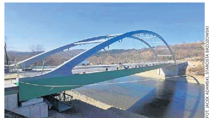
Przeprawa będzie miała ponad 300 metrów długości i 17,3 metra szerokości
