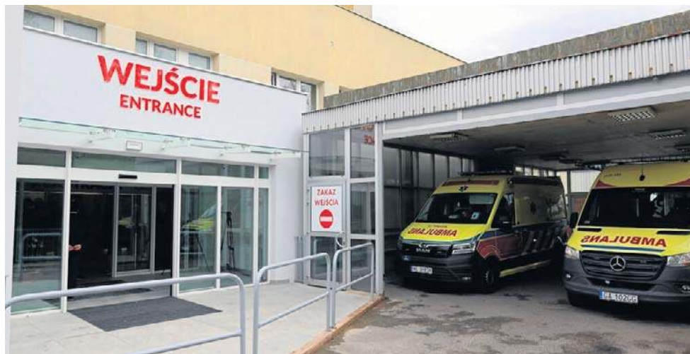
W ramach remontu zmodernizowane zostaną m.in. podjazd i estakada dla karetek
