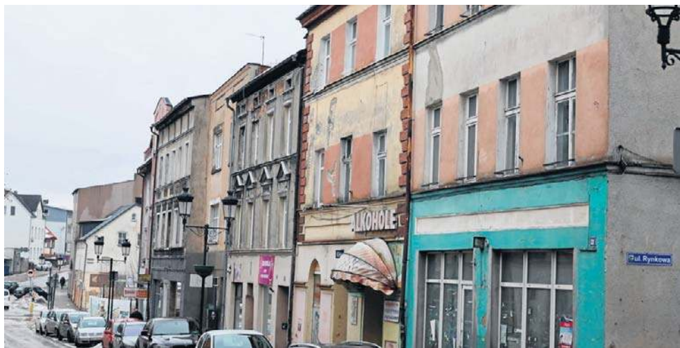
Miasto chce pomóc właścicielom kamienic w Kościerzynie w odnowie elewacji
