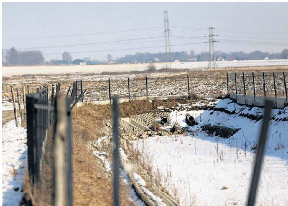
Zbiornik retencyjny przy ul. Folwarcznej, który został zniszczony przez wodę w 2024 roku
