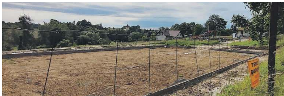
Budowa centrum rekreacyjnego w Porębie Żegoty
