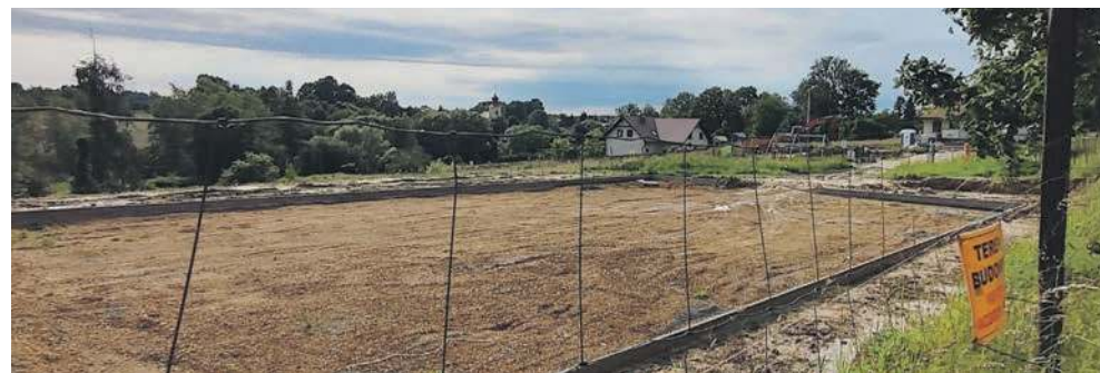
Budowa centrum rekreacyjnego w Porębie Żegoty
