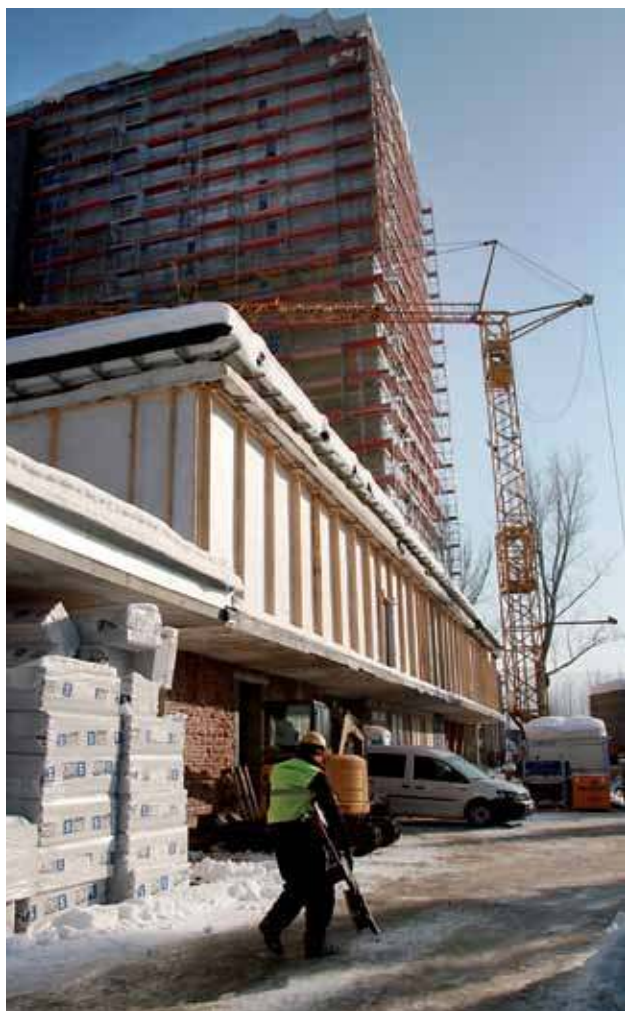
W ciągu miesiąca na budynku dawnego sanatorium Hutnik w Szczawnicy pojawi się nowa elewacja.
