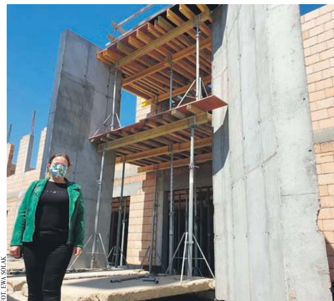
Dyrektor Klaudia Węgrzyn przy powstającym budynku nowej biblioteki w Krzeszowicach
