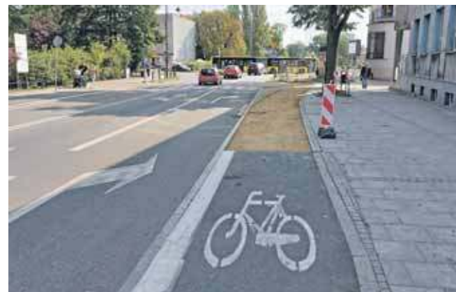
...a w ubiegłym tygodniu asfalt zerwano
