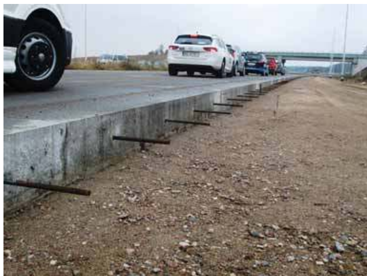
Nawierzchnia betonowa o grubości 36 centymetrów
