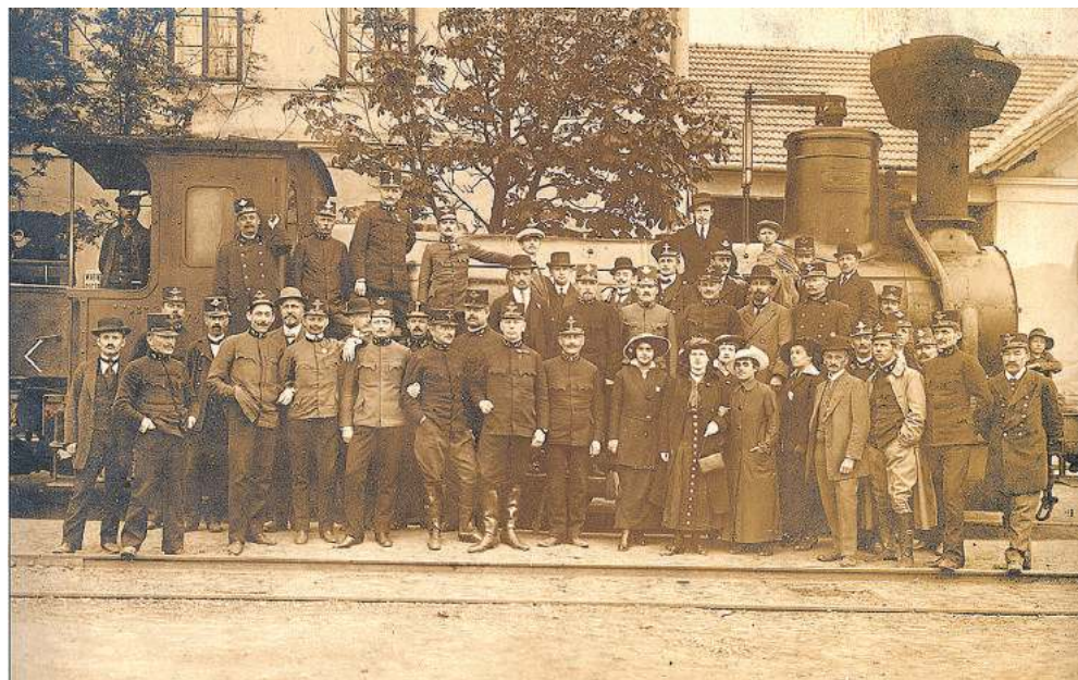
Zdjęcie z wjazdu pierwszego pociągu po otwarciu linii Dembica – Rozwadow. Źródło Muzeum Regionalne Stalowa Wola.
