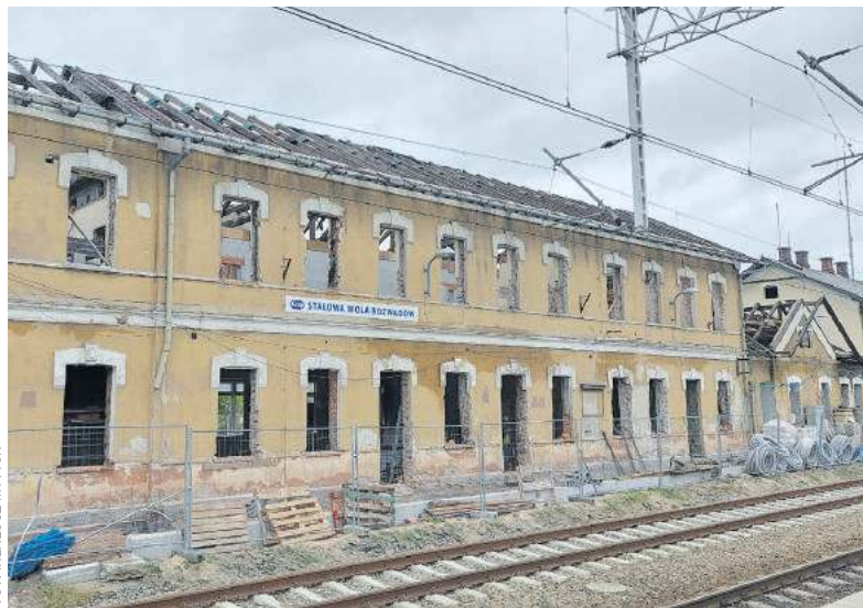
Obecnie zaawansowane prace przy modernizacji dworca kolejowego w Stalowej Woli Rozwadowie sięga 20 procent
