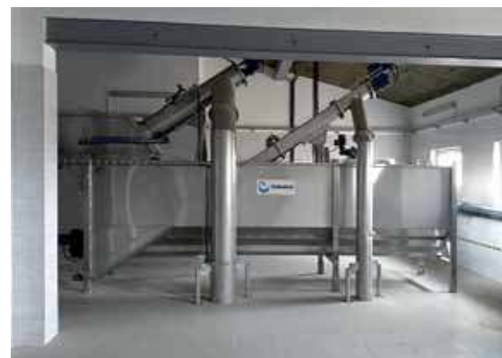
Zamontowany sitopiaskownik w nowym pomieszczeniu hali
