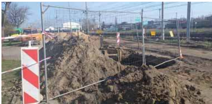
Zabezpieczone miejsce znalezienia niewybuchów przy wlocie na ul. Kolejową
