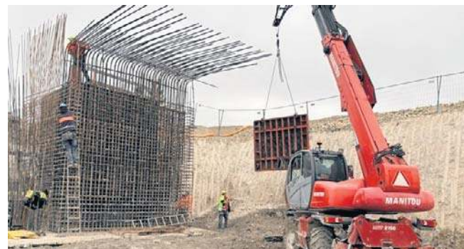
Obwodnica Chełma będzie miała 13,7 km długości. Roboty są zrealizowane w 60 procentach
