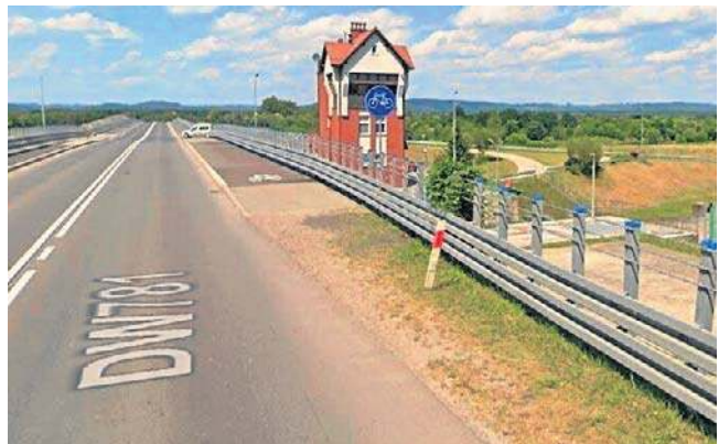
Nowa ścieżka prowadzić będzie m.in. przez most nad Wisłą w Jankowicach
