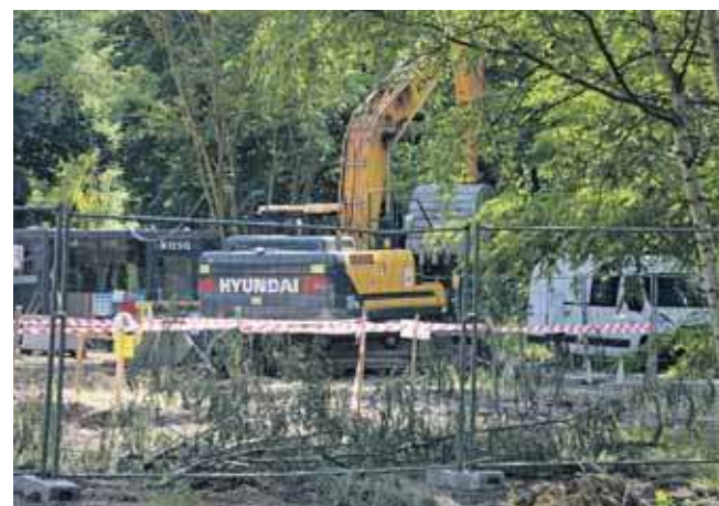
Prace ruszyły pod koniec czerwca, mają zakończyć się w październiku
