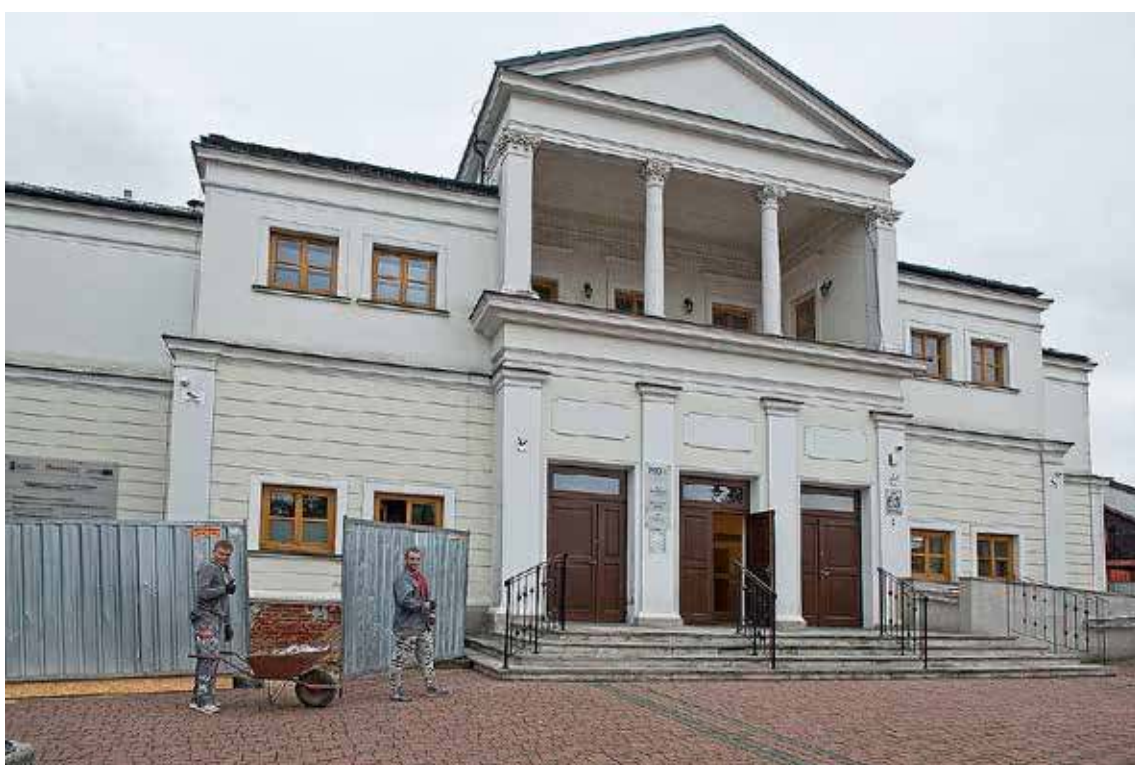
Prace remontowe już się rozpoczęły.
