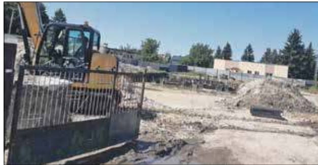
Zakończenie budowy bloku komunalnego przewidziane jest w 2022 r.
