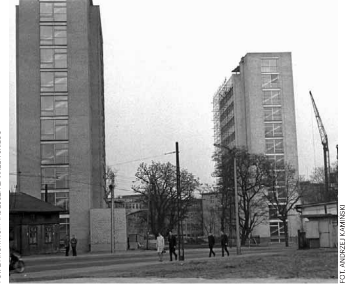
Dwa 11-piętrowe wieżowce przy dawnej ul. Nowickiego. Trzeci był w budowie
