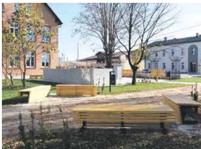
Nowe ławki w przebudowanej części ul. 1 Maja w Kaletach
