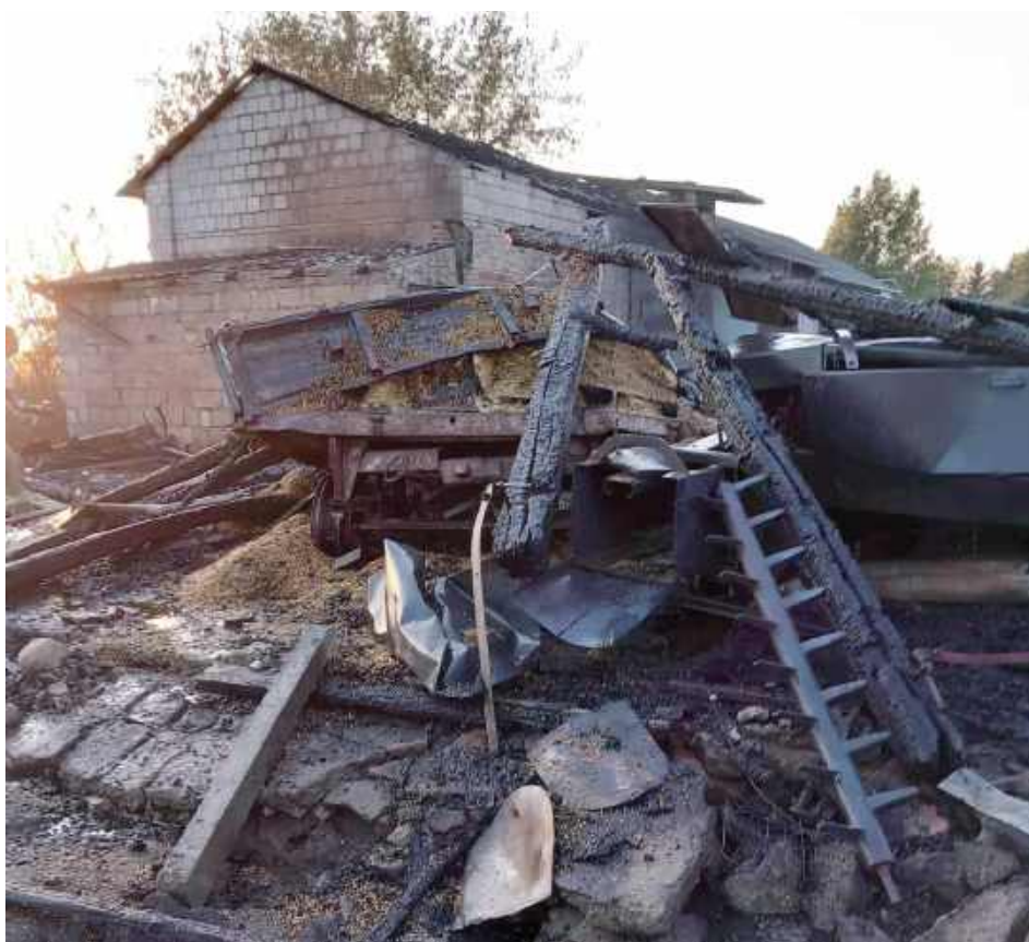
Zniszczenia są ogromne
