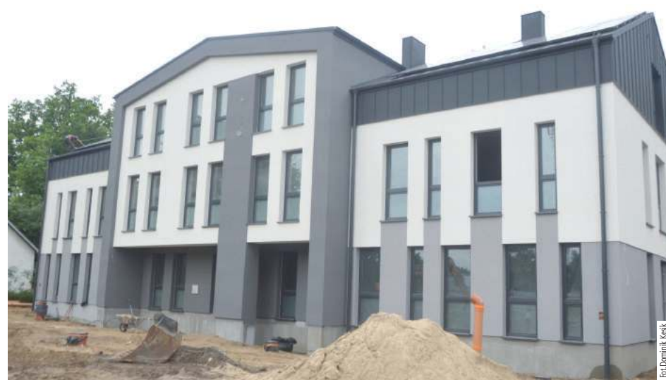
Budynek powstaje od ubiegłego roku. Budowa powoli zmierza ku końcowi
