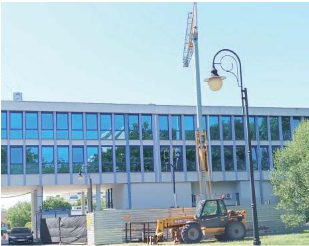
Na tyłach urzędu stanął płot odgradzający plac budowy od trawnika, chodnika i parkingu
