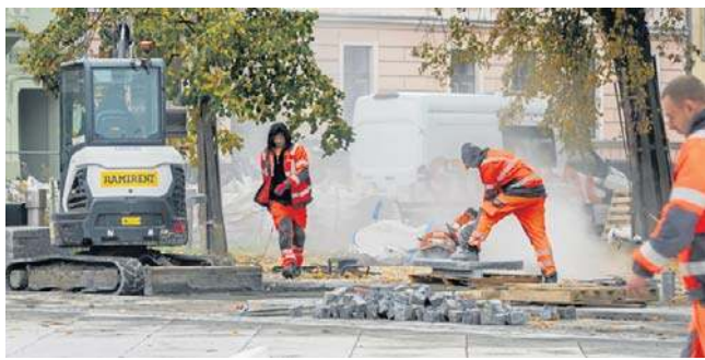
Tak w październiku 2025 roku prezentuje się plac budowy na placu Wolności w Bydgoszczy
