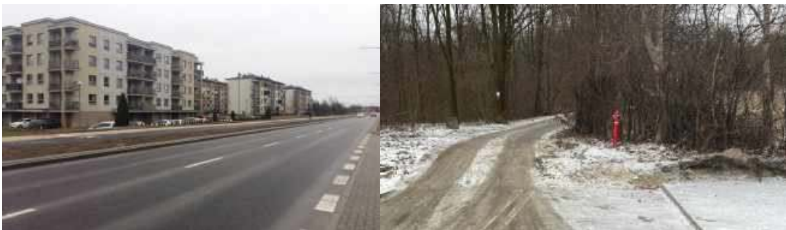
Ostatni odcinek al. Solidarności jest już gotowy, ale na przebudowę czeka jeszcze przebudowa wjazdu w ulicę Wiejską
