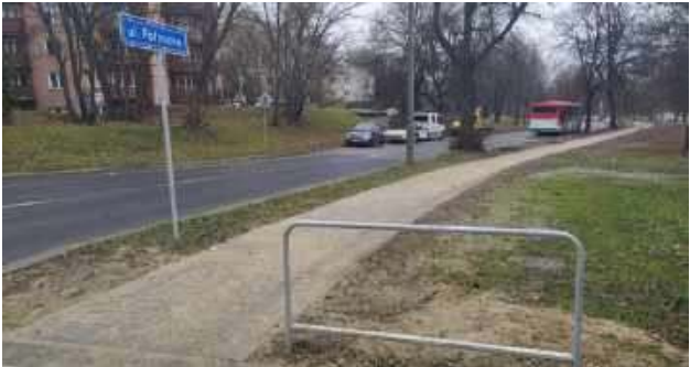
Wyremontowany chodnik przy ul. Północnej
