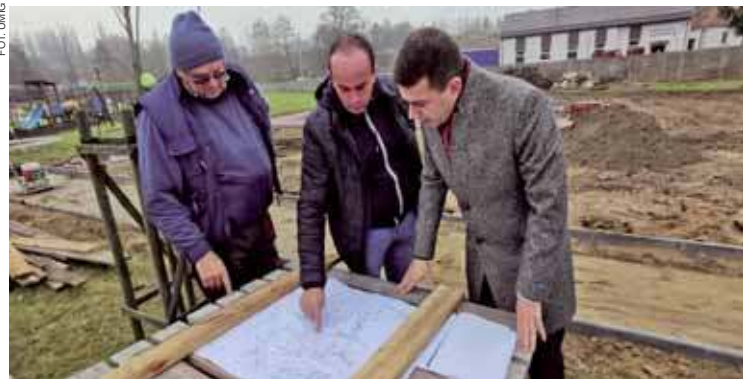
Burmistrz Maciej Sitarek na miejscu budowy tężni
