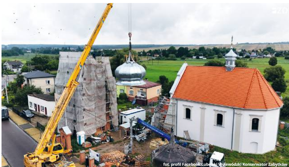
Kopułę dzwonnicy umieszczono już na właściwym miejscu
