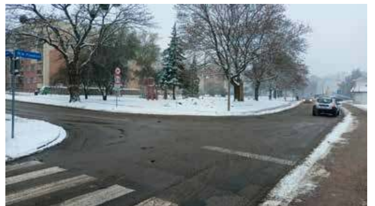
Ulica Puszkina desperacko wymaga remontu
