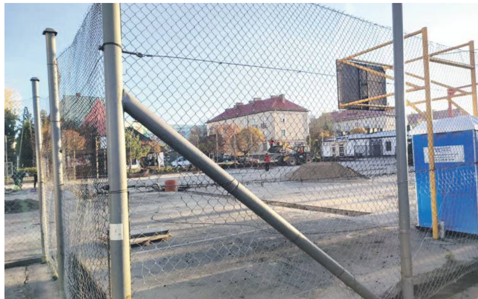
Korty obok hali przy ul. Partyzantów już są w budowie
