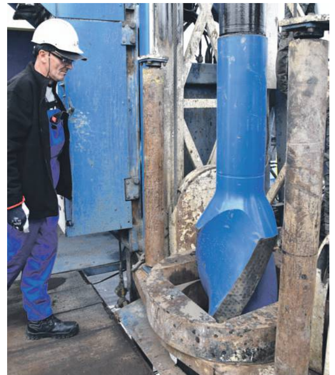
Prace przy wykonaniu próbnego odwiertu ruszyły 4 listopada.
