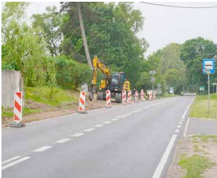
DD Rozpoczęła się budowa chodnika (fot. Gm. Maszewo)
