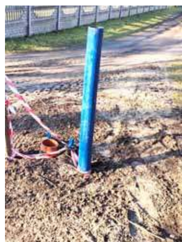
Prace prowadzone są w Budziszewicach oraz Łożnicy (fot. Gm. Przybiernów)
