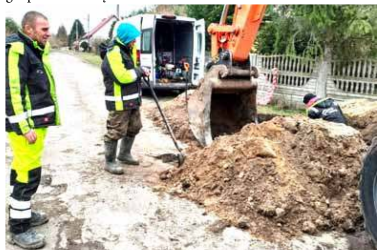
Trwają prace nad budową sieci wodociągowej, stacji uzdatniania wody oraz ujęcia wody (fot. Gm. Przybiernów)
