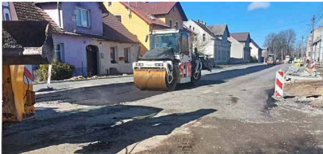
Prace zmierzają ku końcowi (fot. ZZDW)
