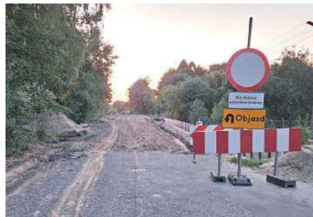
Od strony Rudnik aż do mostu został już zerwany asfalt
