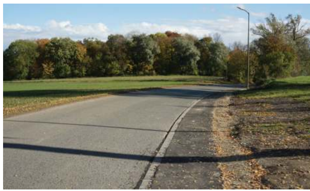
Utwierdzenie pobocza w Dankowicach
