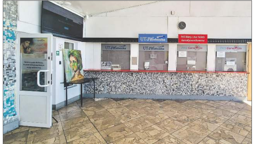
➤ Druga mozaika to abstrakcyjny fryz w odcieniach szarości, umieszczony pod linią okienek biletowych (fot. Mazowiecki Wojewódzki Konserwator Zabytków)
