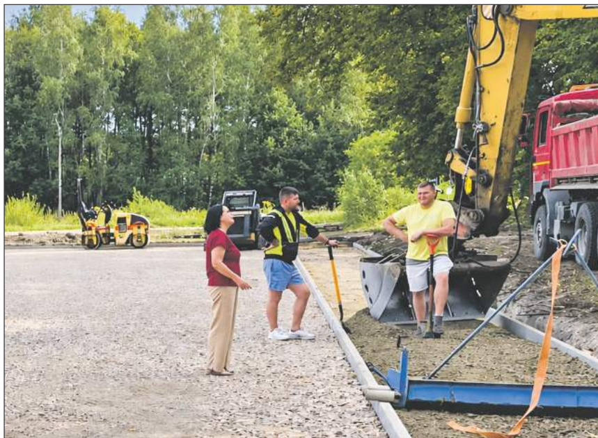
■ Przy Szkole Podstawowej w Starym Goniwilku powstaje boisko wielofunkcyjne. Inwestycja kosztuje ponad 773 tys. zł, z czego blisko 464 tys. zł stanowi dofinansowanie zewnętrzne (fot. Gmina Żelechów)
