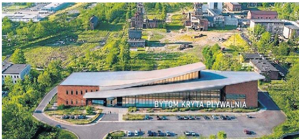
Bytom zbuduje wielki schron na terenie byłej kopalni „Centrum”
