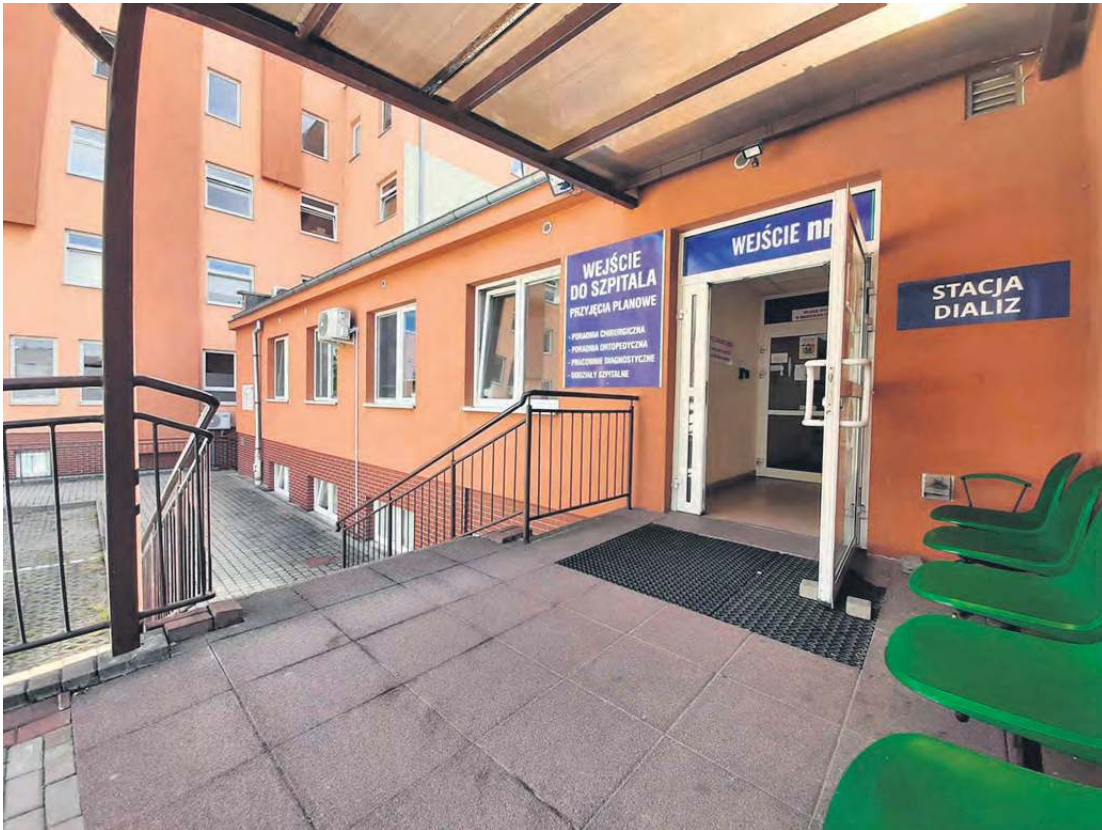
Wejścia do placówki na oddziały i do poradni odbywa się przez wejście nr 3, usytuowane od strony ul. Krzywej.
