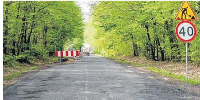
Przebudowa DW 103 Kamień Pomorski - Trzebiatów. Wykonawcą prac jest firma PRD Nowogard SA
