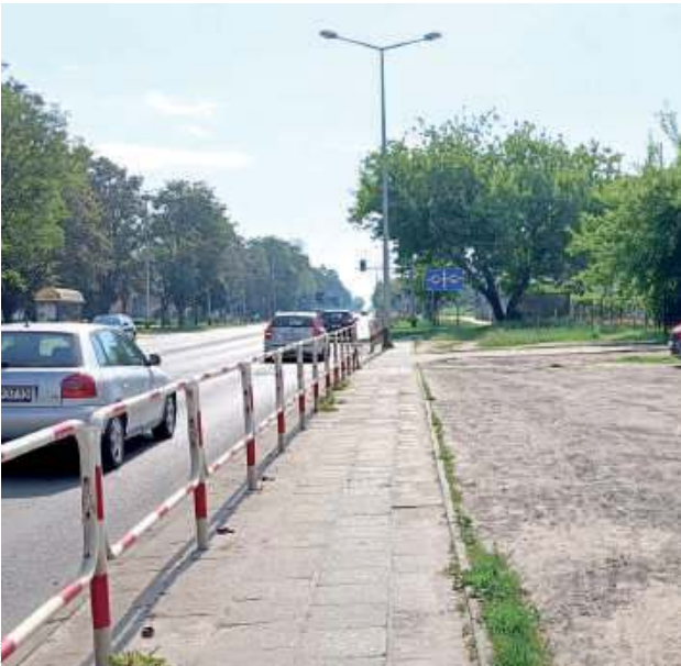
Ścieżki rowerowej brakuje na tym odcinku wzdłuż drogi wojewódzkiej. Chodnik co prawda jest, ale wąski i w rozsypce, a widoków na to, że sytuacja mogłaby się zmienić, na razie brak
