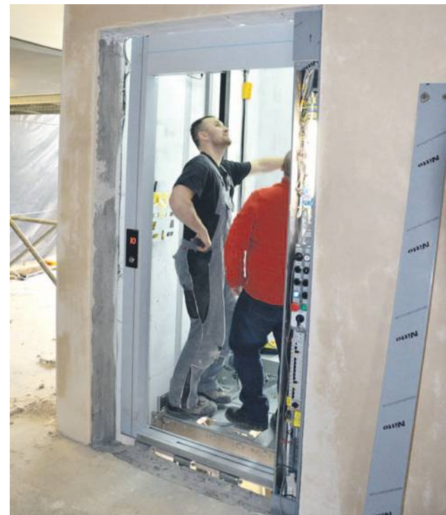
W Zespole Szkół im. Jana Kasprówicza w Jelczu-Laskowicach dobiegają końca prace związane z montażem windy, z której skorzystają osoby niepełnosprawne
