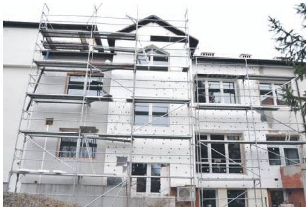
Trwają prace termomodernizacyjne w budynkach Domu Pomocy Społecznej w Oławie
