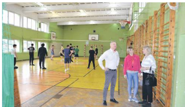
Już wkrótce rozpocznie się termomodernizacja sali gimnastycznej w Zespole Szkół im. Jana Kasprówicza w Jelczu-Laskowicach, na zdjęciu stan obecny
