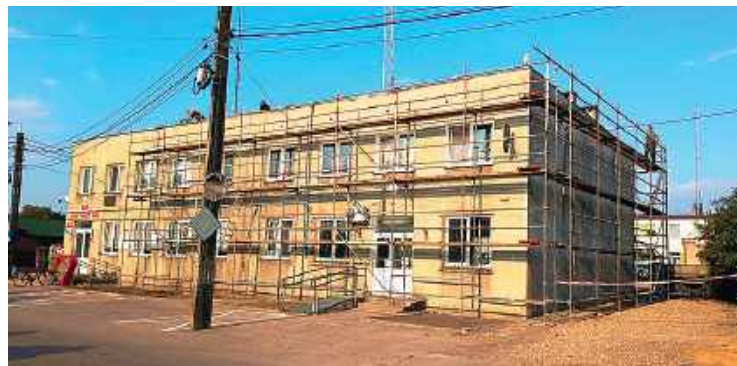
Termomodernizacja budynku urzędu gminy
