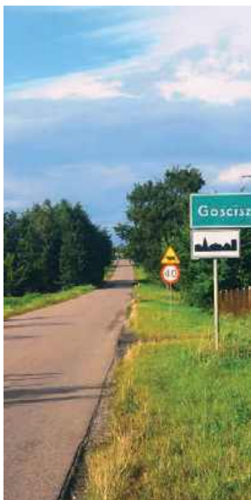
Droga Zielona – Gościszka przed rozbudową
