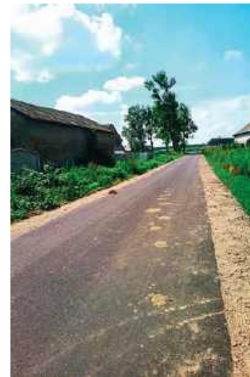
Wyremontowana droga w Jonnem
