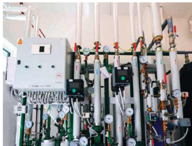
Węzeł ciepłowniczy, stąd rozprowadzana jest ciepła woda z budynków do poszczególnych mieszkań
