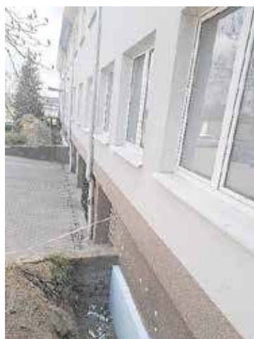
Prace rozpoczęły się od docieplenia fundamentów budynku UG
