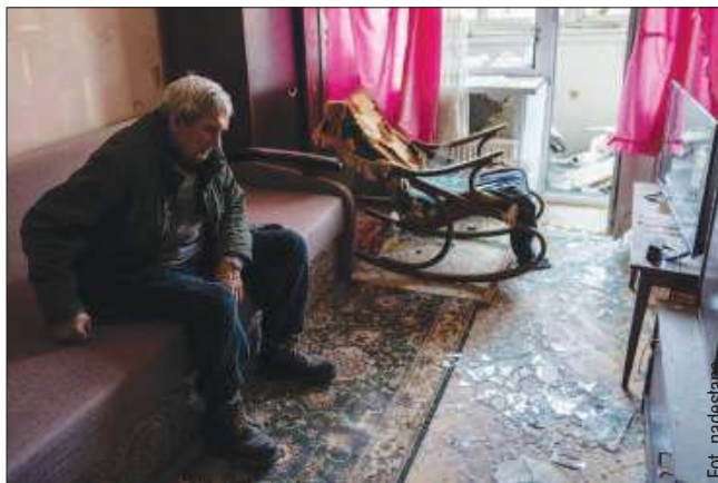
Często zniszczenia raketowe dotyczą zwykłych domów.
