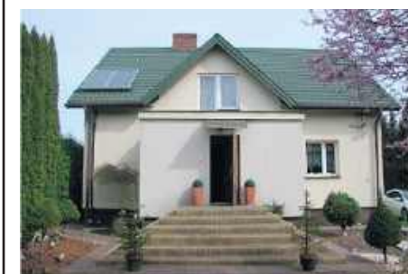
Budynek mieszkalny – widok od strony południowej
