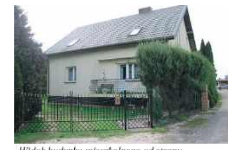
Widok budynku mieszkalnego od strony północno-zachodniej.
