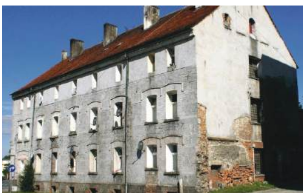
Budynek przy ul. Pocztowej w Strzelinie, potocznie nazywany „belwederem”
