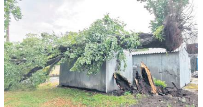
Uszkodzony garaż i samochody. Najwięcej było jednak zablokowanych dróg.
