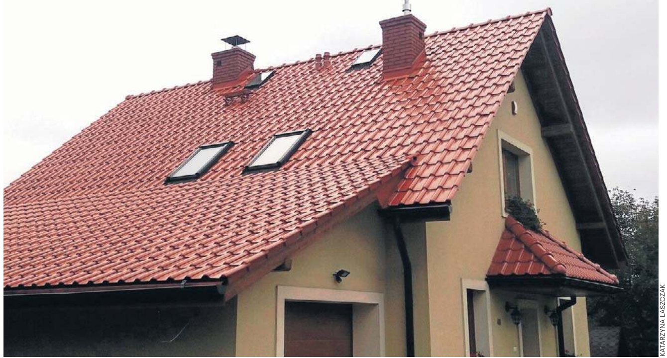
Na wygląd dachówki ceramicznej wpływa nie tylko jej kształt, ale także rodzaj wykończenia powierzchni.
