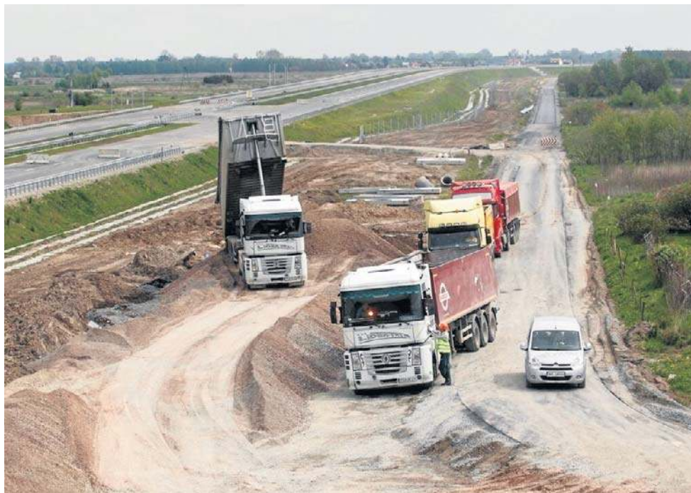
Rozbudowa A4 Krzyżowa - Legnica (35 km) podzielona będzie na dwa odcinki
