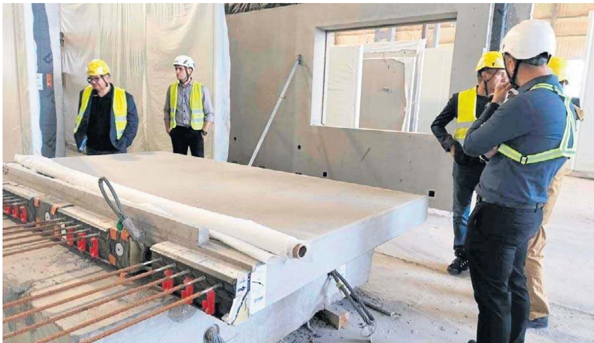
Przed rozpoczęciem budowy schronu władze powiatu zwiedziły fabrykę prefabrykatów Pekabeksu
