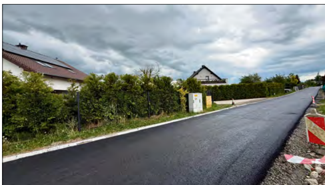
Przebudowa ulic Zielonej w Chróście.
