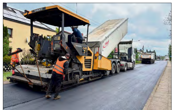
Remont nawierzchni na ulicy Kamiennej w Ciepeliowicach.
