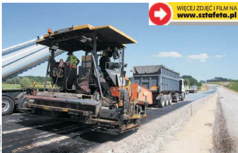
17 czerwca układano pierwszą warstwę podbudowy bitumicznej w okolicy budowy mostu nad Sanem na wysokości Zarzecza i Nowej Wsi
