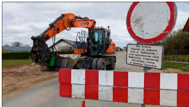
Prace na ul. Nakielskiej w Tarnowie Opolskim już trwają – kierowcy muszą liczyć się z czasowymi utrudnieniami.
